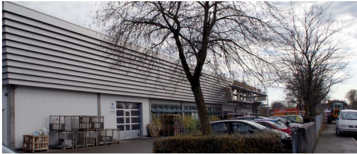
Endlich: Die Umbauarbeiten der WfbM Erding befinden sich in ihrer finalen Phase.
